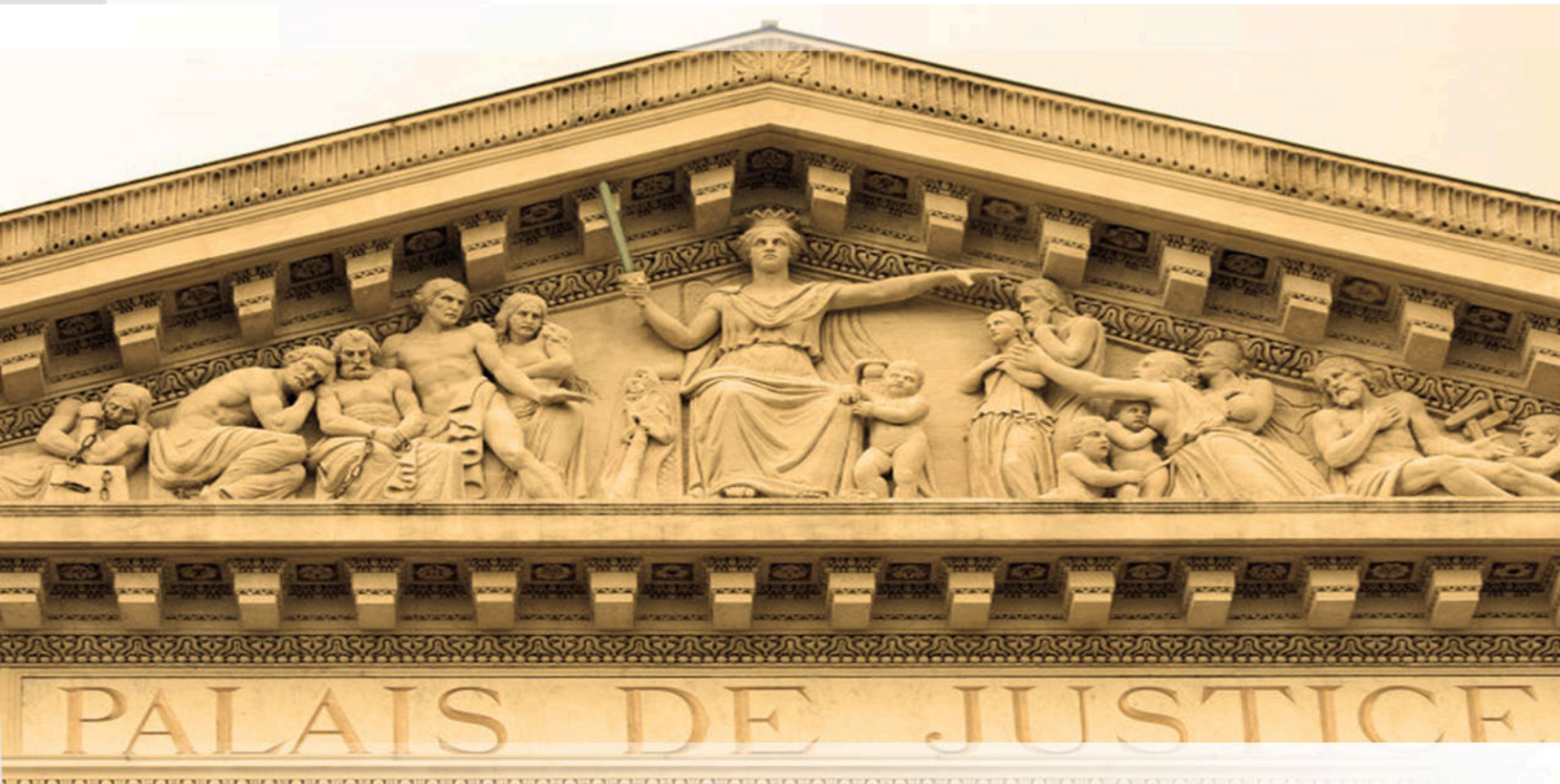
Foto: Fachada superior principal del Palacio de Justicia en Nimes, Francia.
